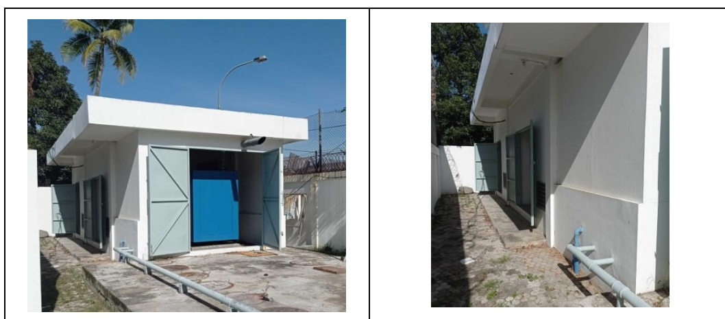
Figura 3 – EDIFÍCIO CONSTRUÍDO DESTINADO AO GENERATOR HOUSE E MOTOR ROOM
