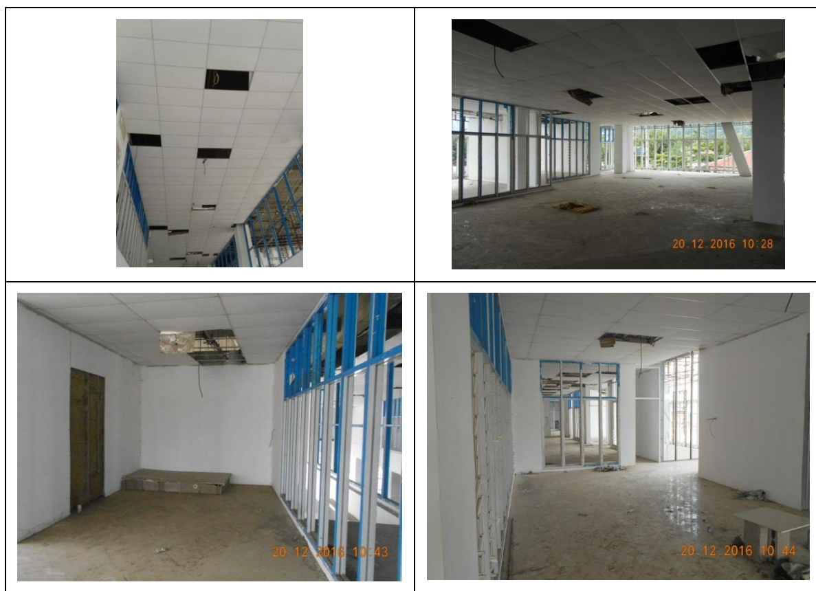
Figura 1 – TRABALHOS REALIZADOS PELA TLIC - CEILING
