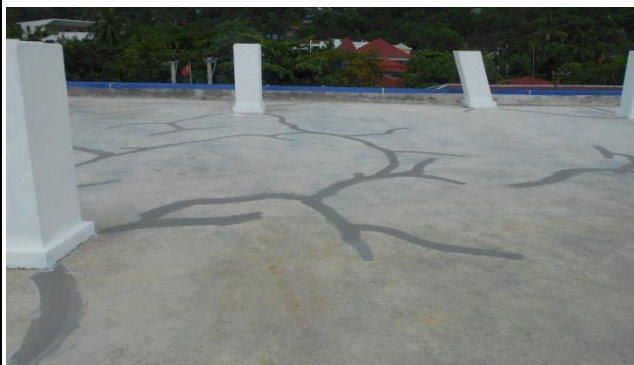
35. Cobertura do edifício após trabalhos de impermeabilização
