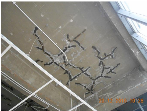
17. Trabalhos de reparação das fissuras da cobertura
