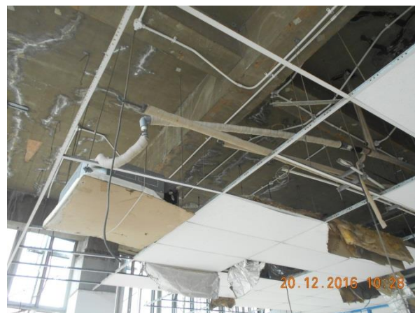
18. Trabalhos de reparação das fissuras existentes na cobertura e tecto falso destruído por causa das infiltrações da água (1)
